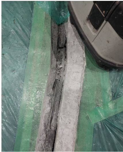
左 損傷部除去、中 損傷部除去後拡大、右 補修後(黄土色部分)
