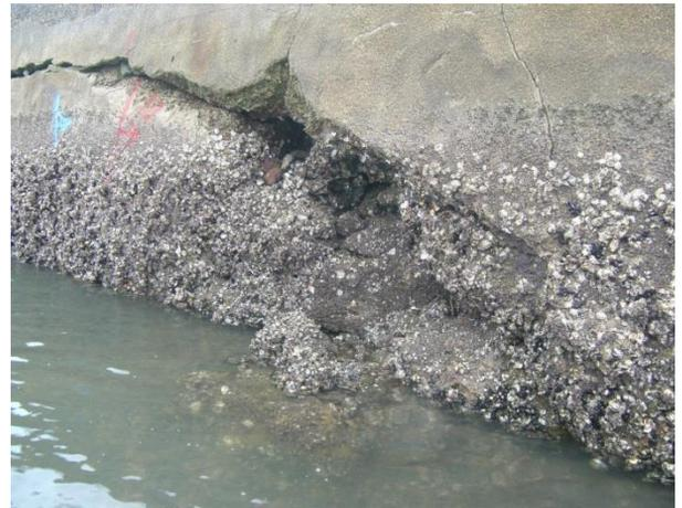
内部の石積みが崩落し、徐々に間詰め材の砂利なども流出している。
