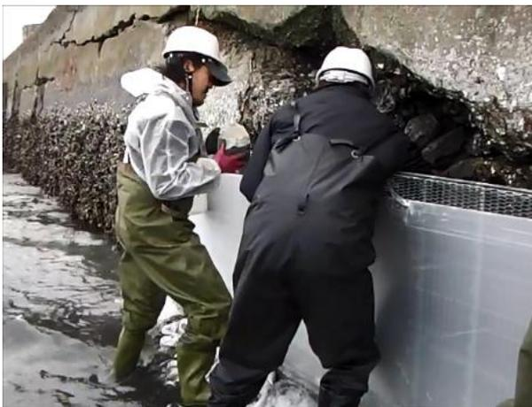
金属製残置式型枠と樹脂パネルを使用し、川床から1m部分の高さまで打設。
