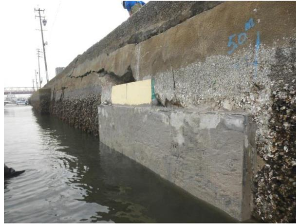
欠損部は型枠を当て、空隙が発生しない様に下部より充填していきます。
