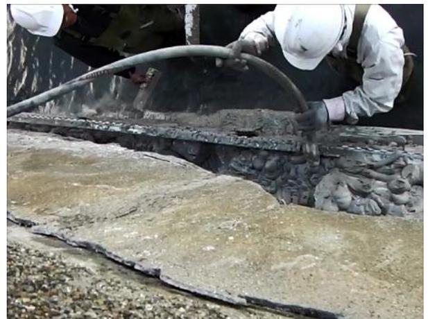
EAGLE8専用練り機を使用して連続で流し込み打設。
