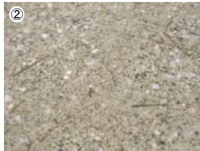
24時間稼働の国際空港。開港後の経年劣化により舗装表面の荒れが目立ち始めている。鋼繊維が飛散すると航空機エンジンの故障原因となる為、薄層でも超速硬性と高強度を併せ持つEAGLE8をご採用いただいた。打設厚さは1.5mm,2.0mm,3.0mm
