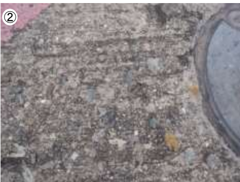
24時間稼働の国際空港。開港後の経年劣化により舗装の荒れ・割れが目立ち始めている。給油空地指定箇所では不燃性・耐油性・超速硬性と高強度を併せ持つEAGLE8を採用いただいた。
