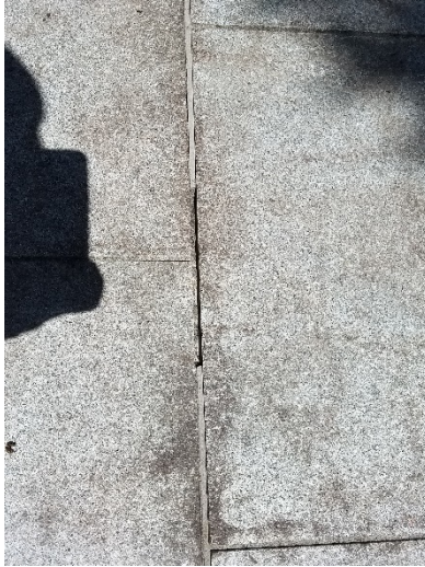
左 沈下による隙間、中 目地材破損、右 青色→部
