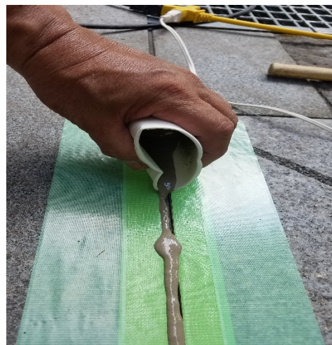
カップより流し込み、上の写真と同様に、ヘラで押し込むように均しました。
