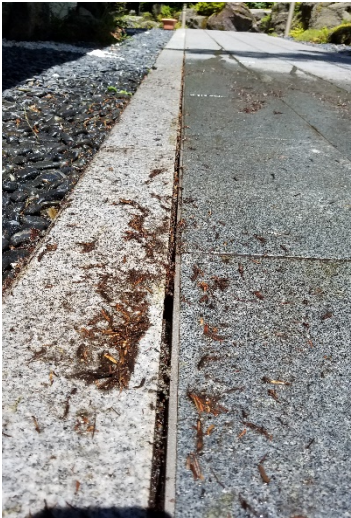
左 沈下による隙間、中 目地材破損、右 青色→部
