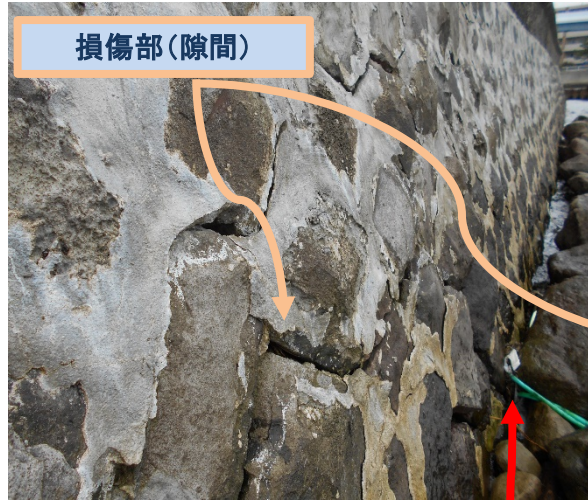
損傷部(陥没)
