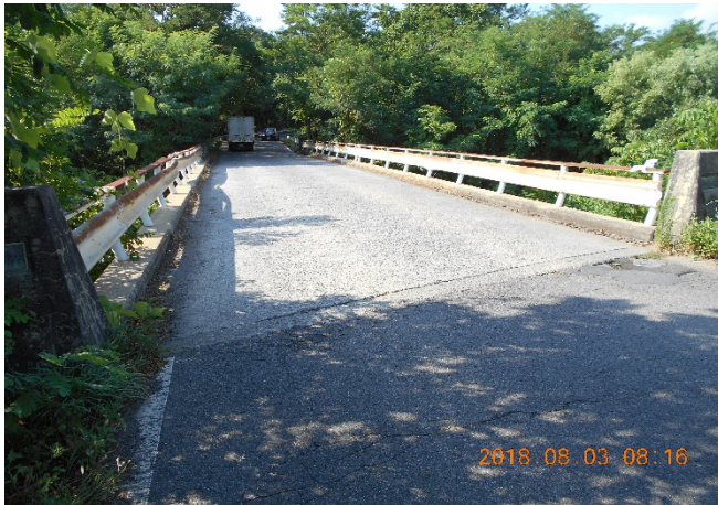
室町橋全景 巾5.5m × 長さ33m 約182㎡
