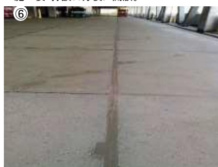
施工後：打設30分後に開放。
