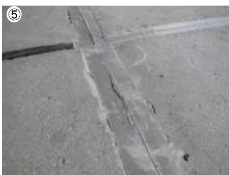
施工後：必要に応じ、樹脂板で誘発目地を設けておきます。
