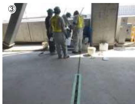
下地処理：不具合部を除去し清掃。
