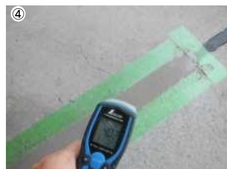
施工後：打設部不意金を養生テープでマスキング。
