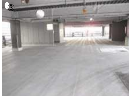
下地処理：塗膜層を除去しコンクリート面を露出。プライマーは要りません。
