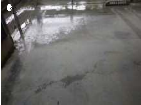
施工後：打継ぎが出来るので、区画を区切って施工できます。
