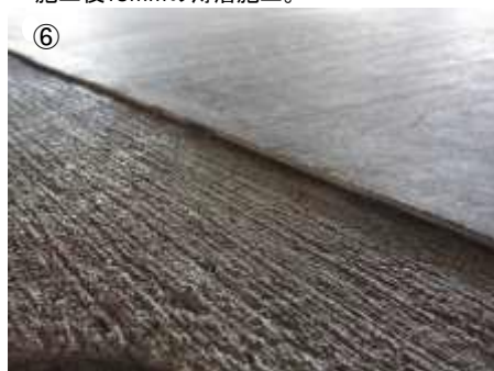
施工後：3mmの薄層施工。
