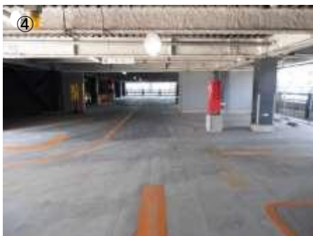
施工後：打継ぎが出来るので、区画を区切って施工できます。
